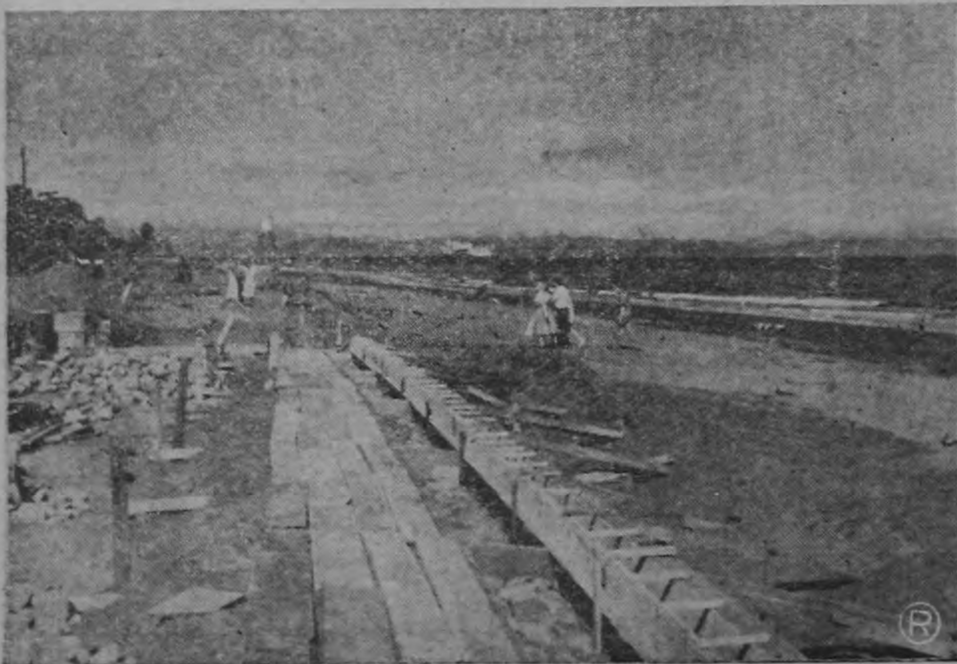
Este aspecto de los trabajos que se están realizando a lo largo de la playa de Puntarenas, para conseguir un gran paseo, que vendrá a embellecer la ciudad de Puntarenas. Es un paso hacia la transformación de nuestro puerto sobre el Pacífico. Las obras fueron visitadas por el Presidente Figueres en su pase para Guanacasté.
